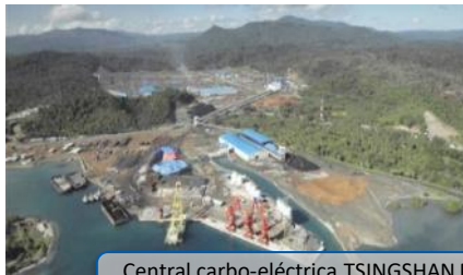
Central carbo-eléctrica TSINGSHAN Park Indonesia
